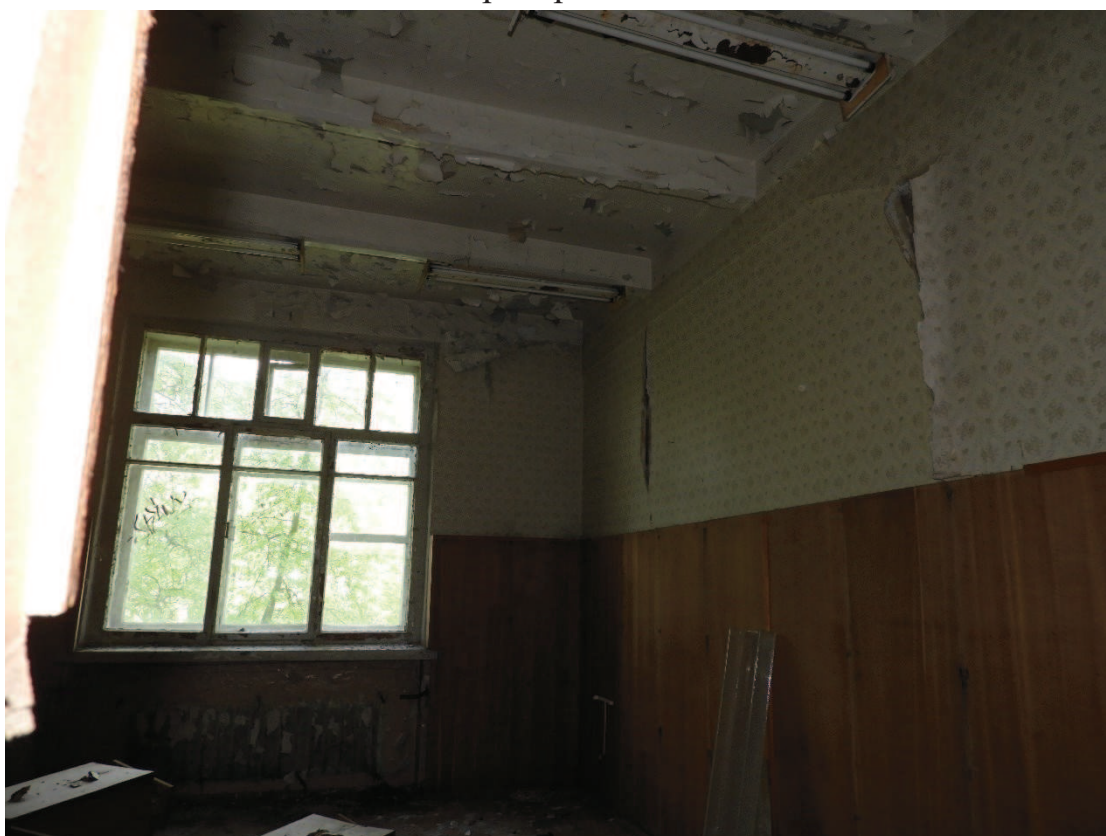
48. Интерьер. Западное помещение на втором этаже в северной части здания.
