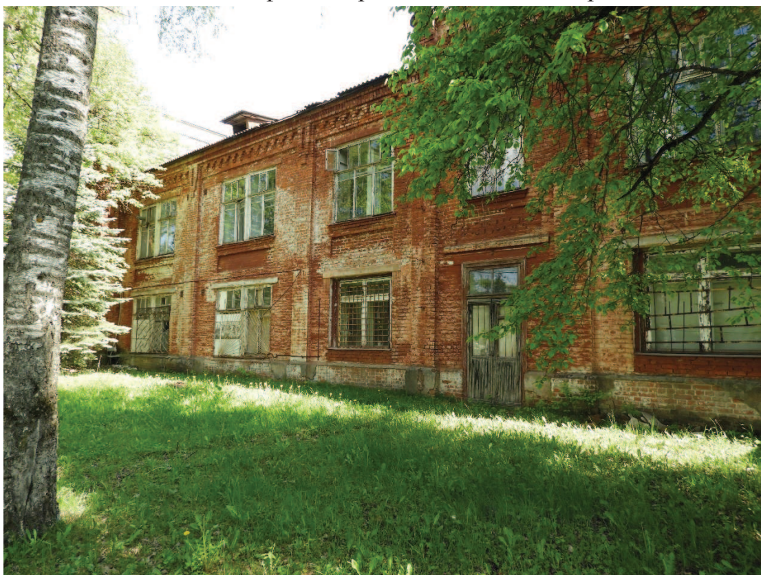
20. Западный фасад. Северная часть.
