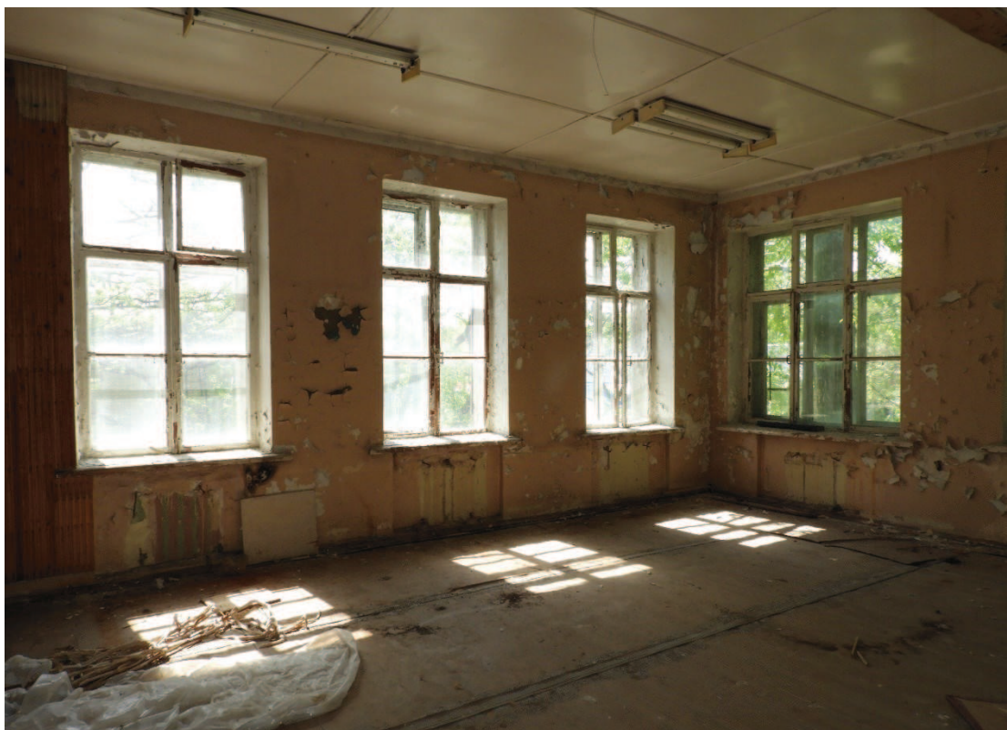
47. Интерьер. Помещение на втором этаже в центральной восточной пристройке.
