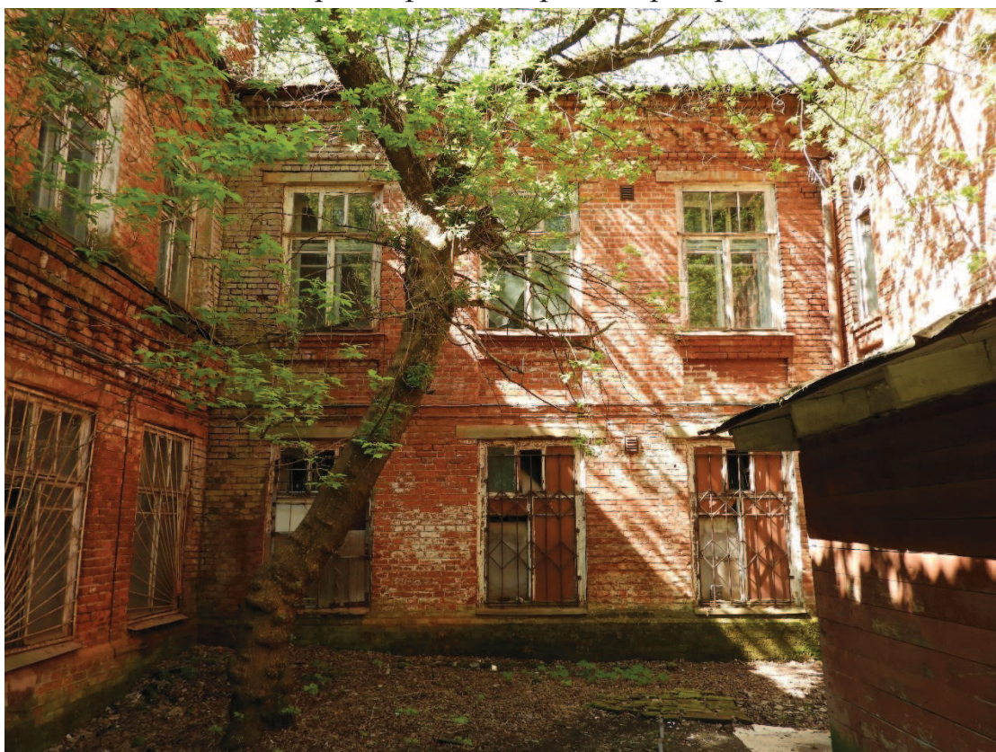
12. Южный фасад восточной пристройки.
