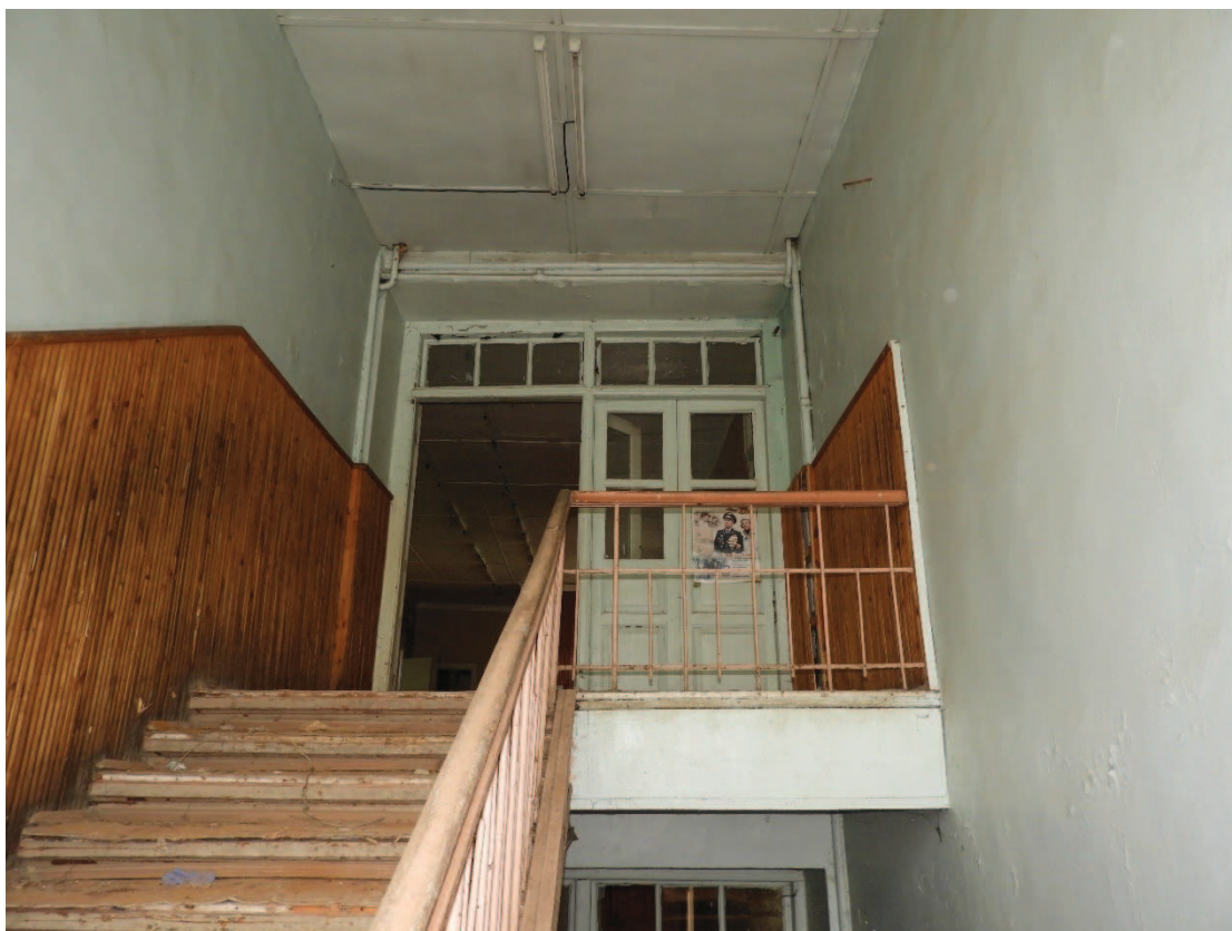
27. Интерьер. Южная лестница. Лестничный марш и площадка второго этажа.
