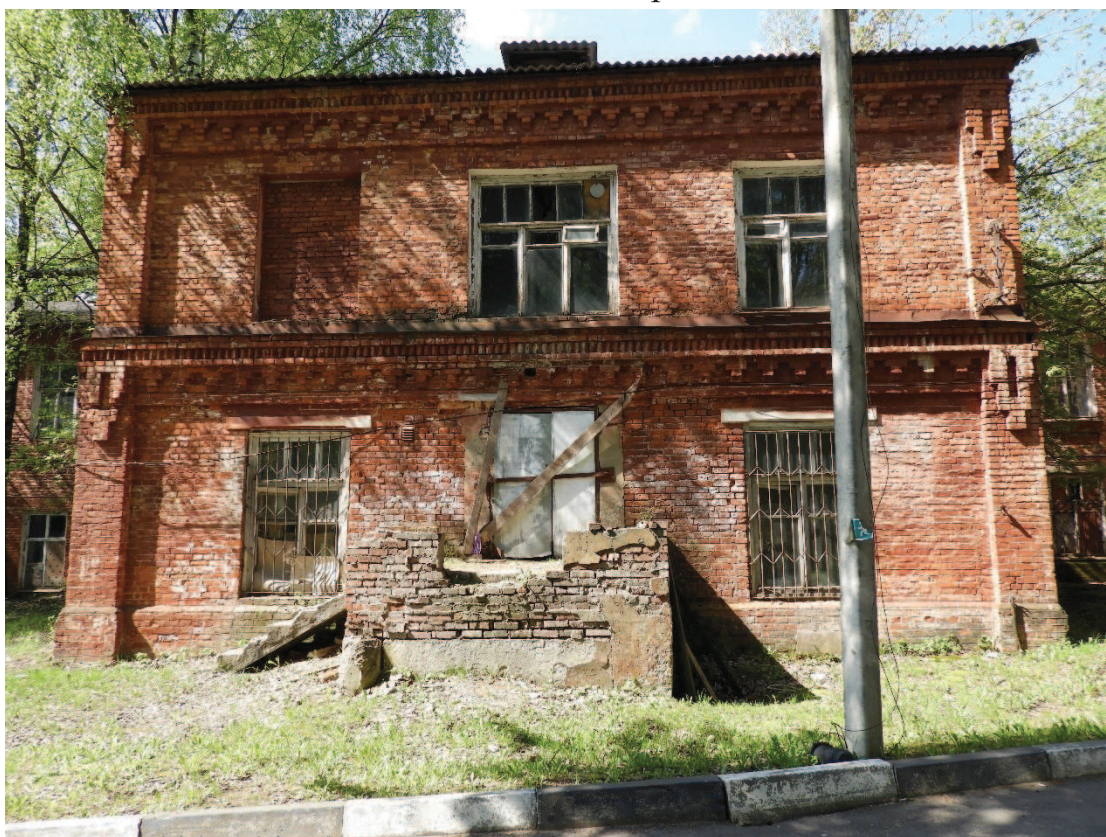
10. Восточный фасад северной пристройки.
