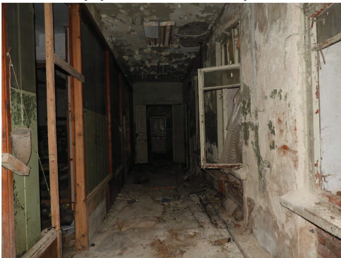
38. Интерьер. Северный коридор на первом этаже.
