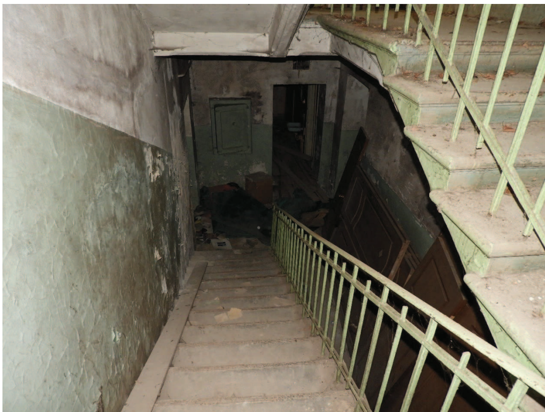
55. Интерьер. Северная лестница на первом этаже.
