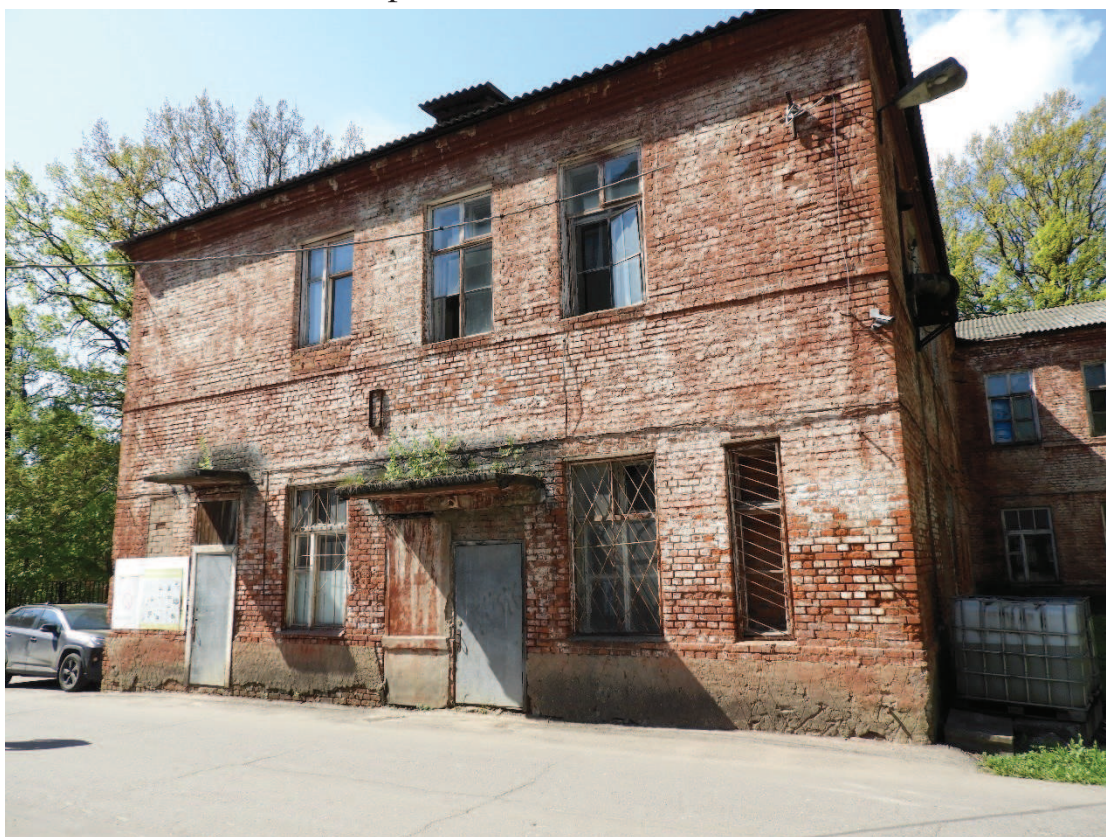
2. Восточный фасад южного крыла здания.
