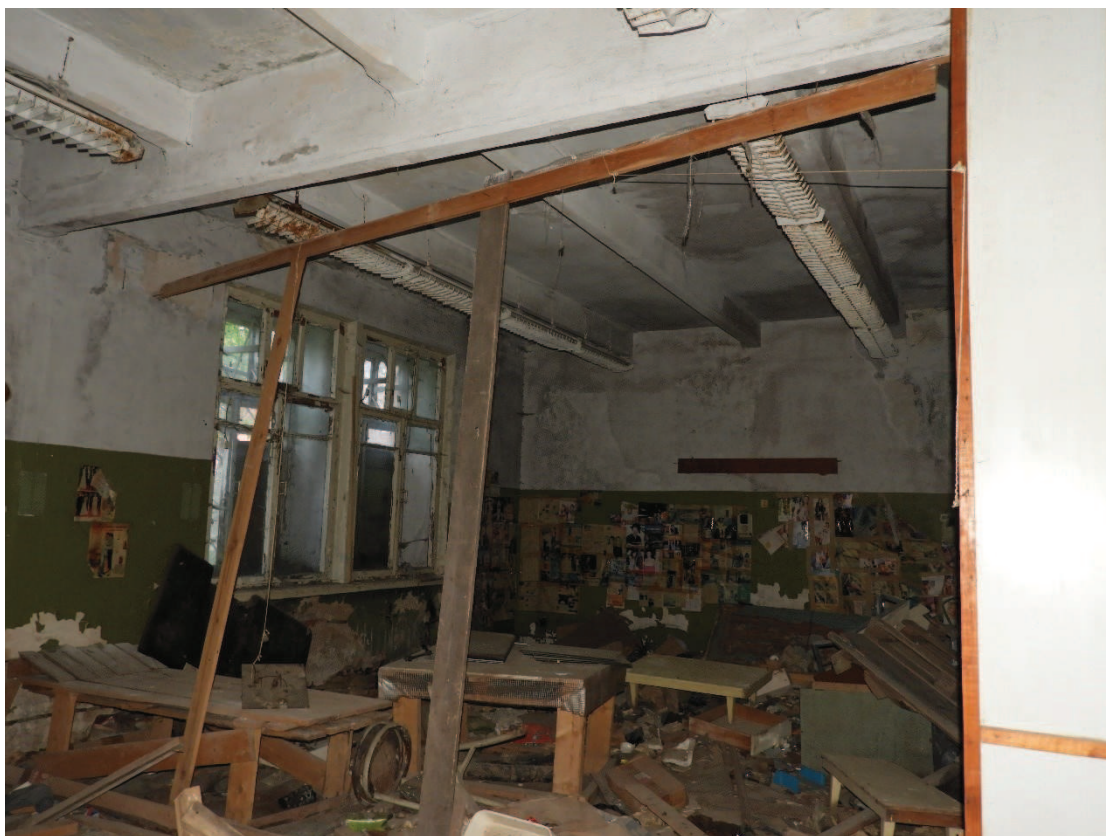
39. Интерьер. Западное помещение на первом этаже (северная часть).
