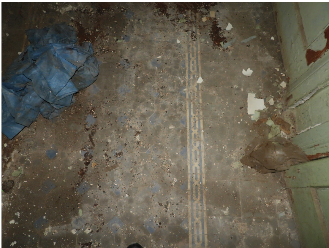
54. Интерьер. Пол на втором этаже в северном помещении из метлахской плитки.
