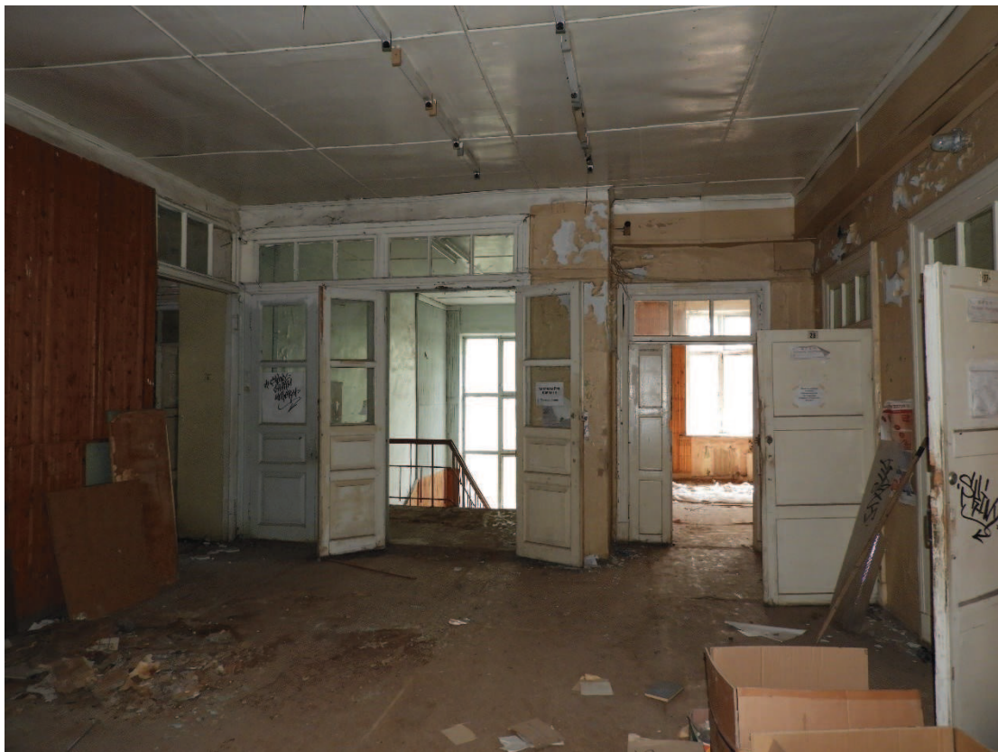
40. Интерьер. Холл на втором этаже. Вид с севера.
