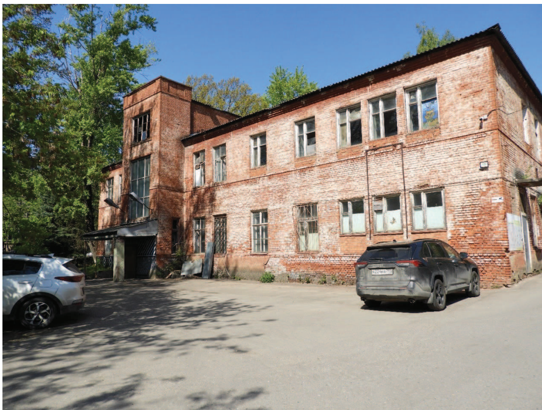
1. Южный фасад здания. Вид с юго-востока.
