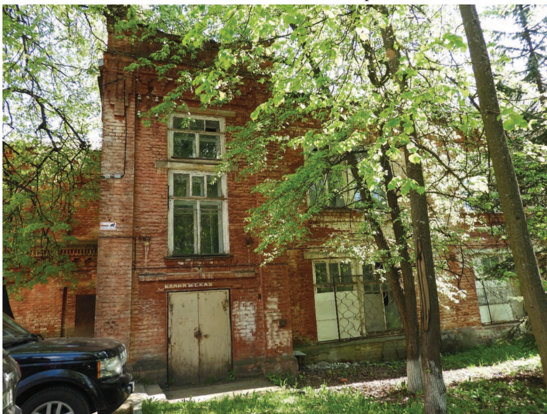
18. Западный фасад. Северная часть.
