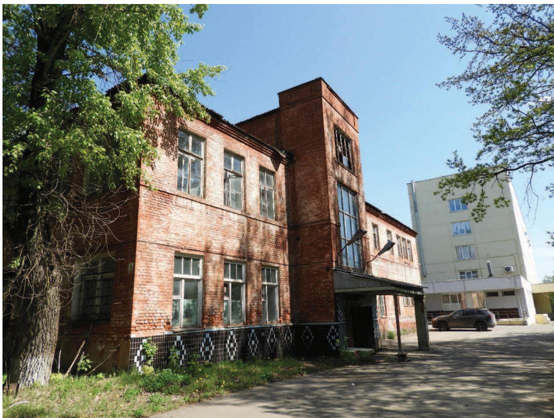
23. Южный фасад. Вид с юго-запада.
