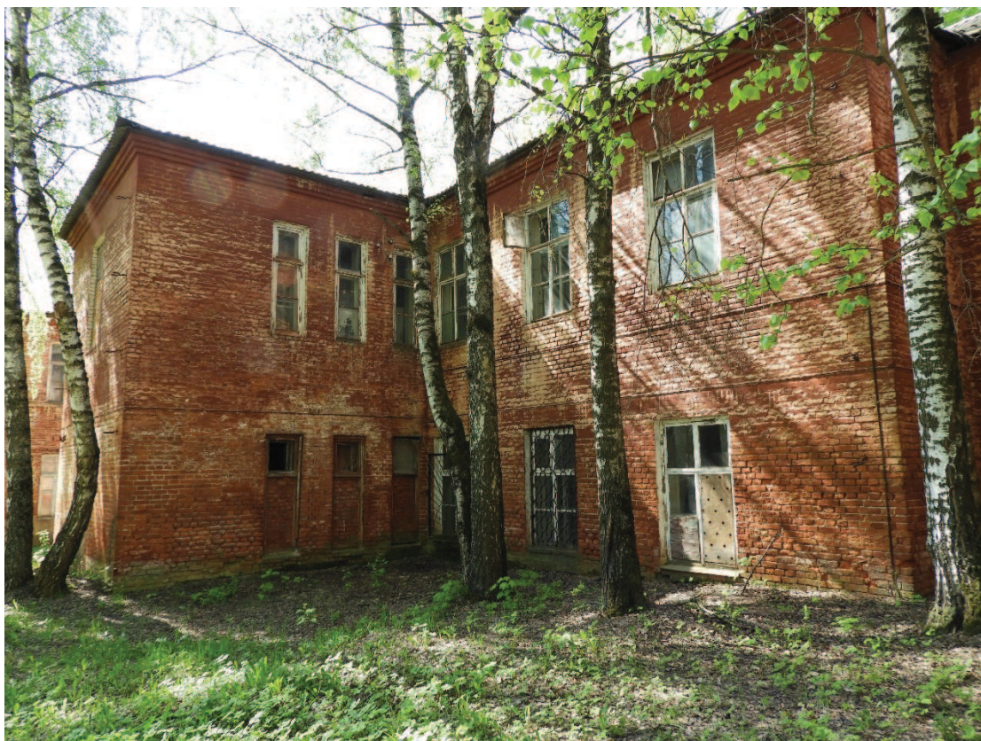
7. Северный фасад центральной пристройки.
