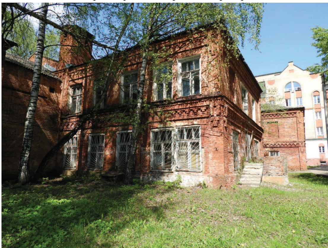
8. Южный фасад северной пристройки.
