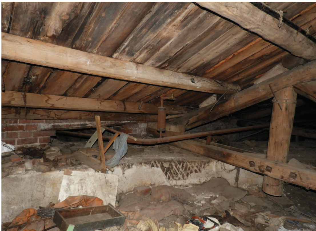
58. Интерьер. Подкровельное пространство. Обрешётка.
