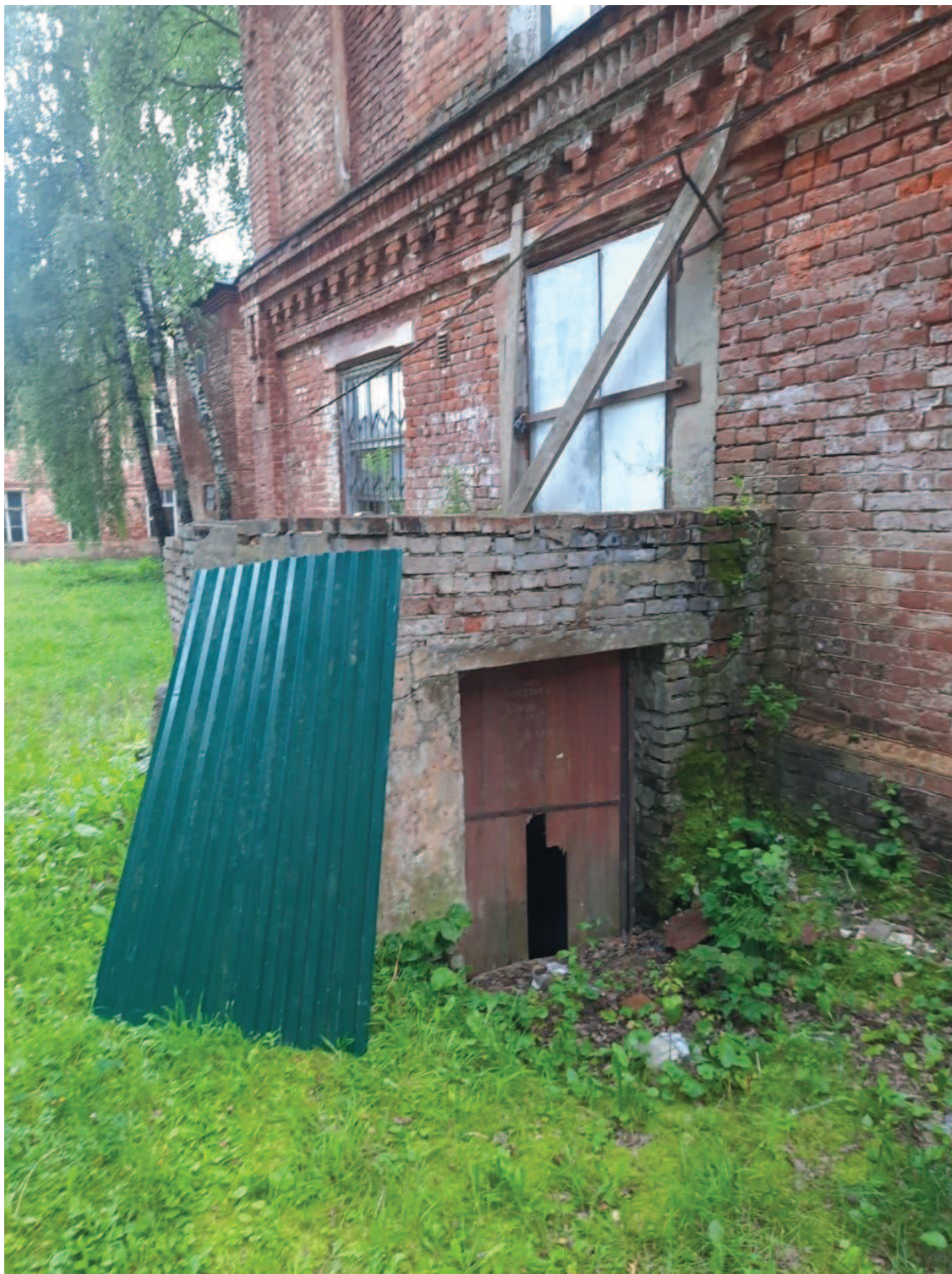
60. Восточный фасад северной пристройки. Вход в подвал.
