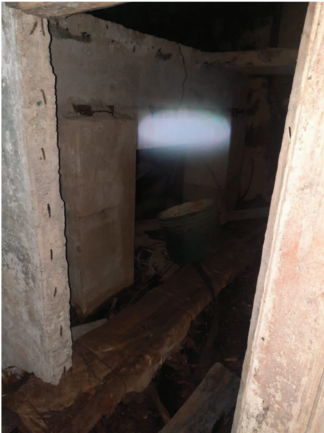
61. Фрагмент интерьера подвала под северной пристройкой.
