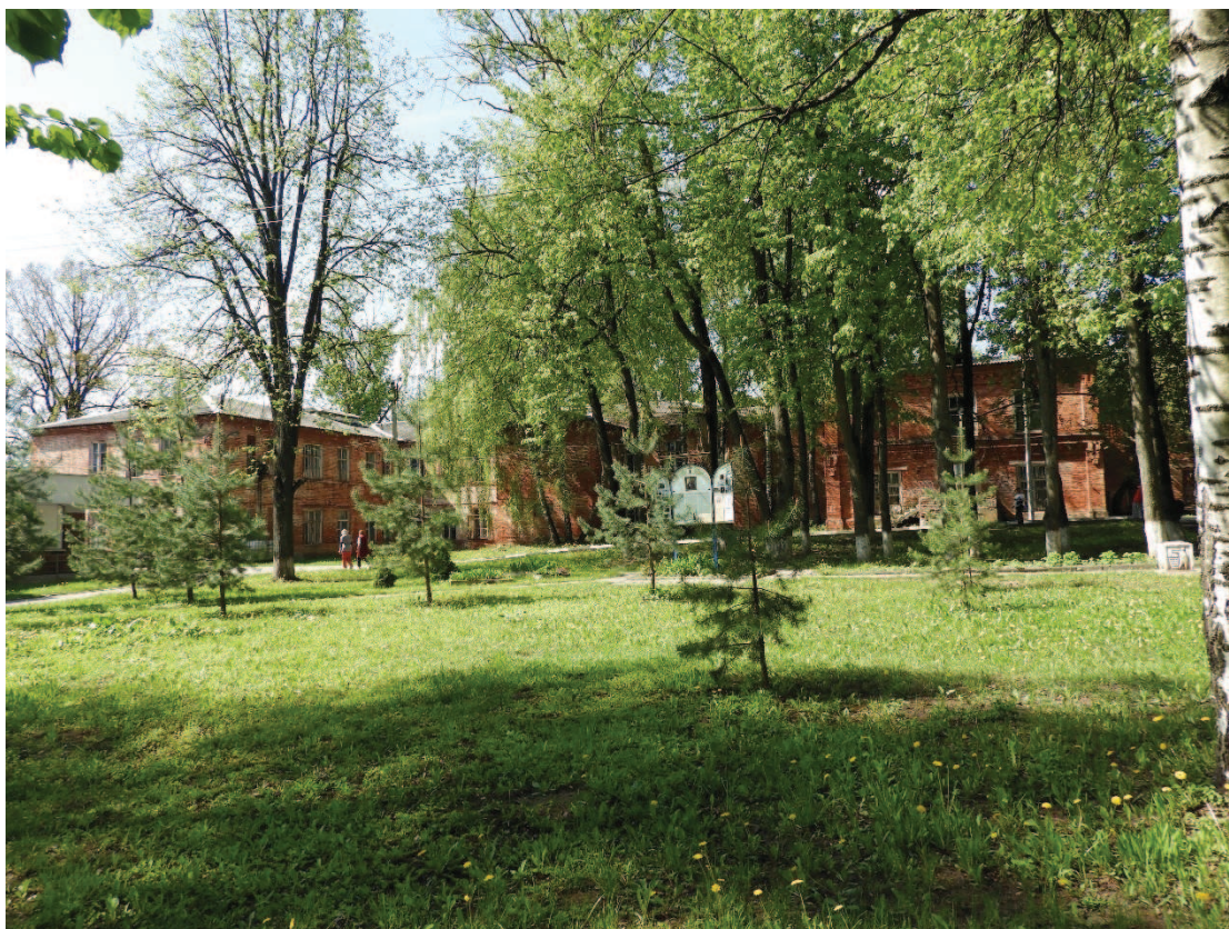
3. Восточный фасад здания.
