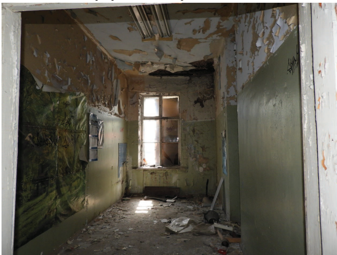
42. Интерьер. Западное помещение на втором этаже.
