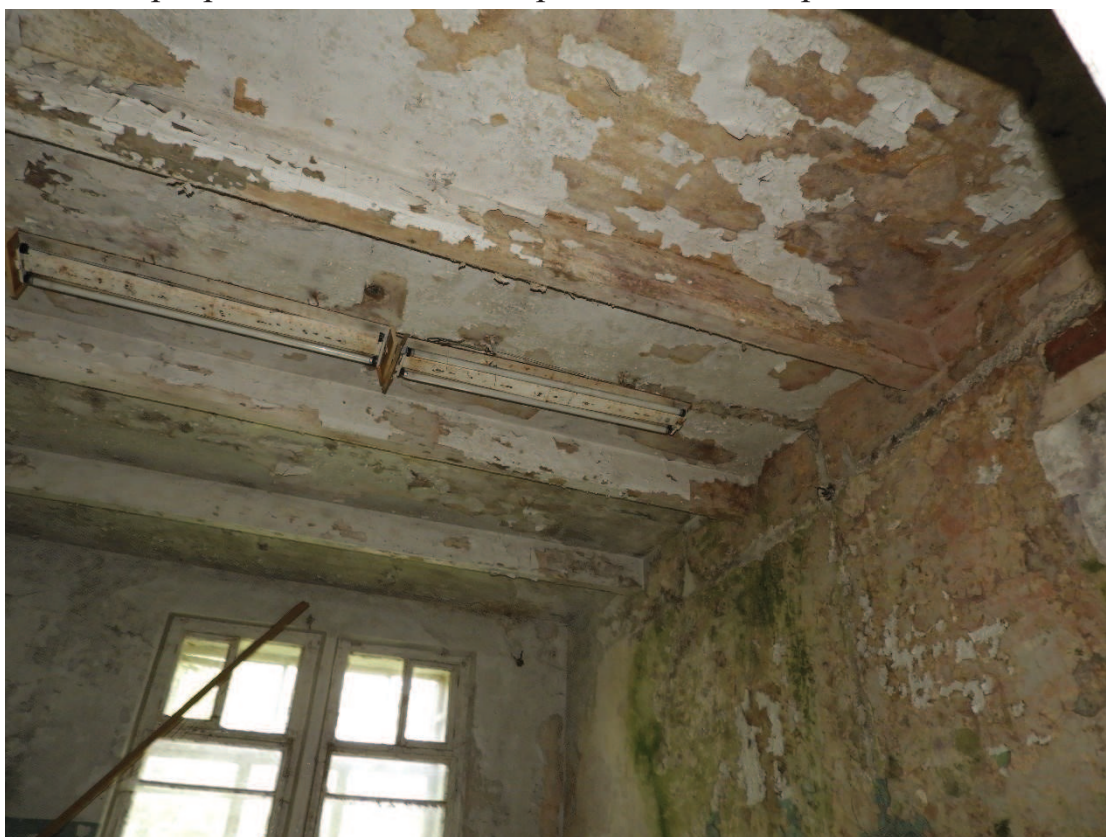
52. Интерьер. Перекрытие в помещении на втором этаже в северной части здания.
