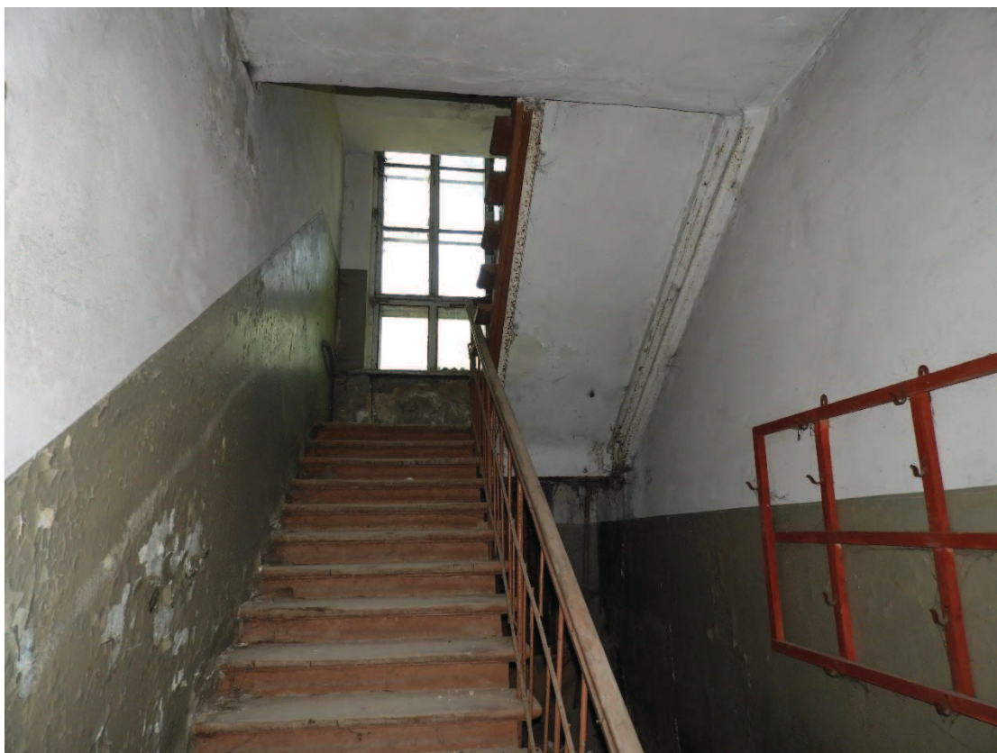
35. Интерьер. Западная лестница на первом этаже.
