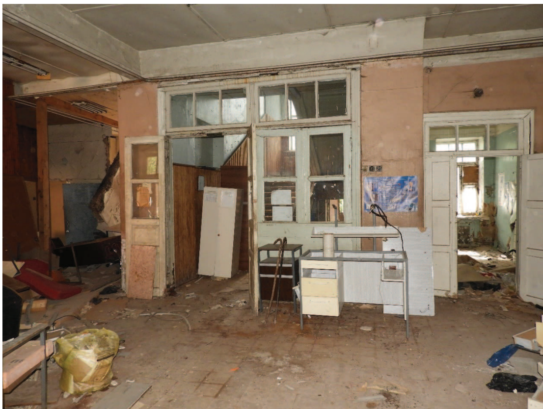
20. Интерьер. Помещение холла на первом этаже. Вид с севера.
