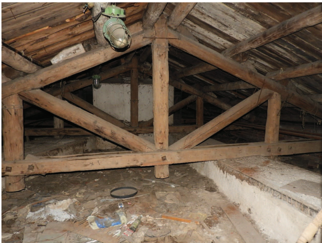
57. Интерьер. Подкровельное пространство. Стропильная система.
