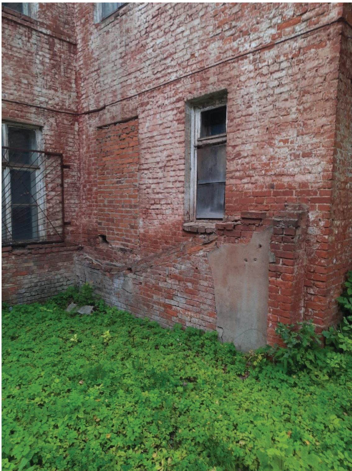
59. Заложенный вход в один из подвалов здания.
