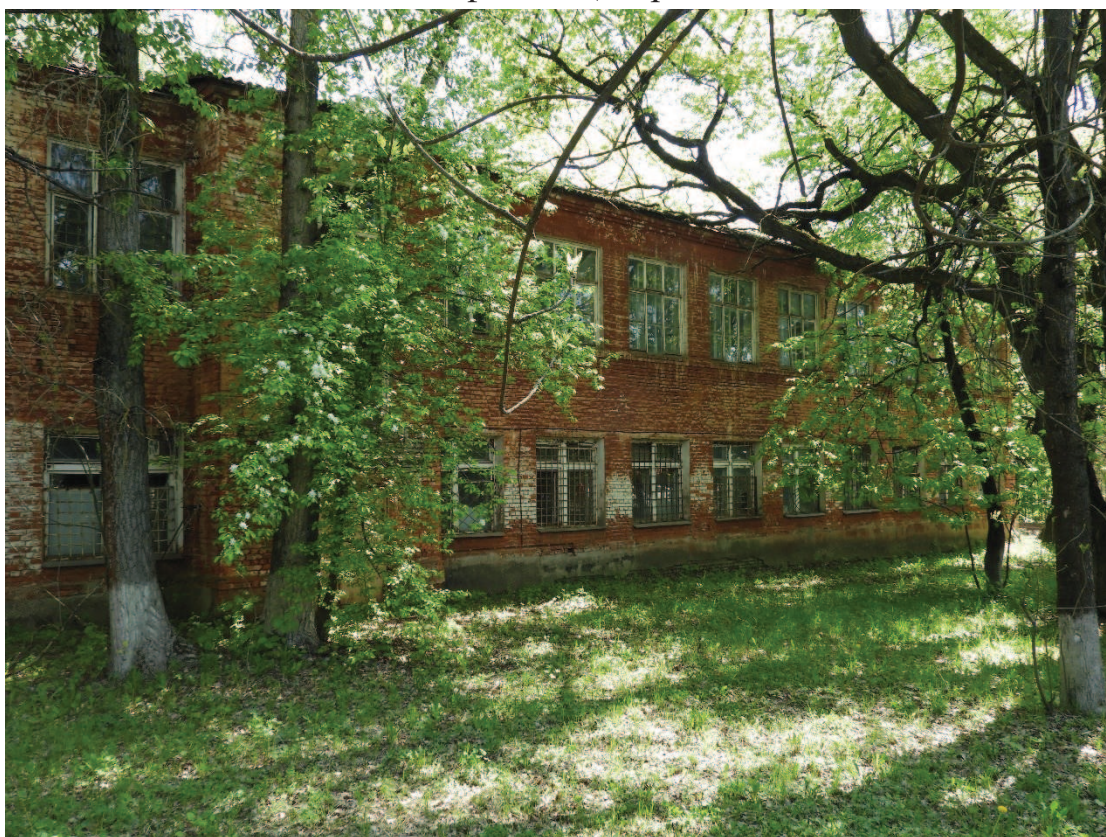
22. Западный фасад. Южная часть.
