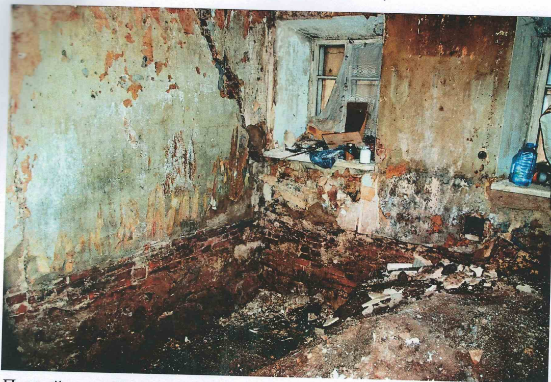
33. Первый этаж. Интерьер. Помещение в северной части здания, Фундамент.
