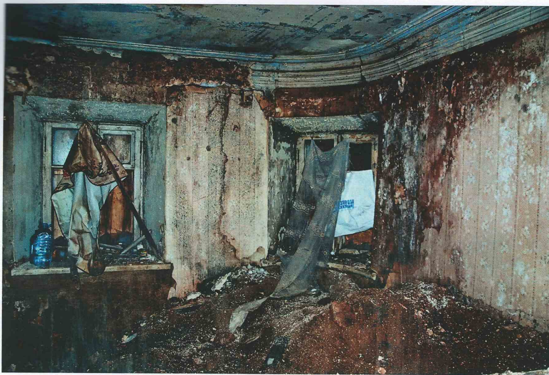
31. Первый этаж, интерьер. Помещение в юго-западном углу здания.
