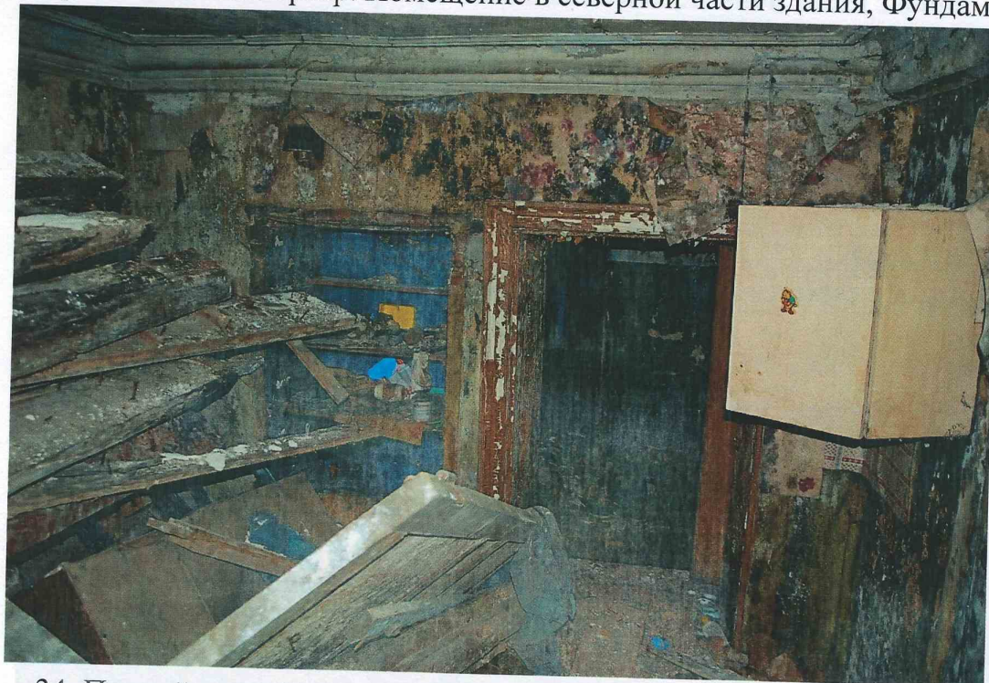
34. Первый этаж. Интерьер. Помещение в восточной части здания.
