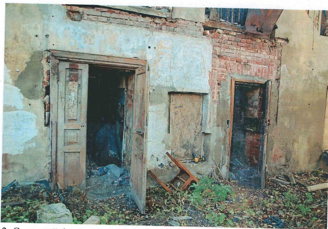
12. Северный фасад. Фрагмент. Входы во второй и первый этажи здания.
