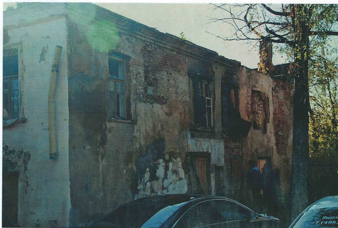
3. Северный фасад. Вид с северо-востока.
