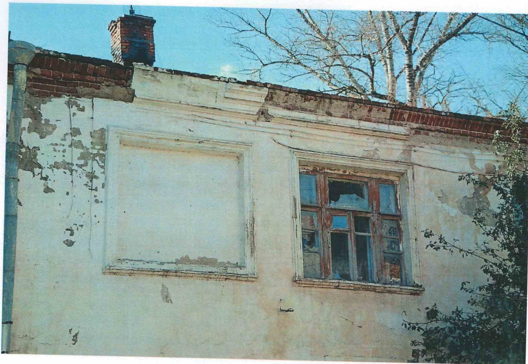
11. Восточный фасад. Фрагмент.
