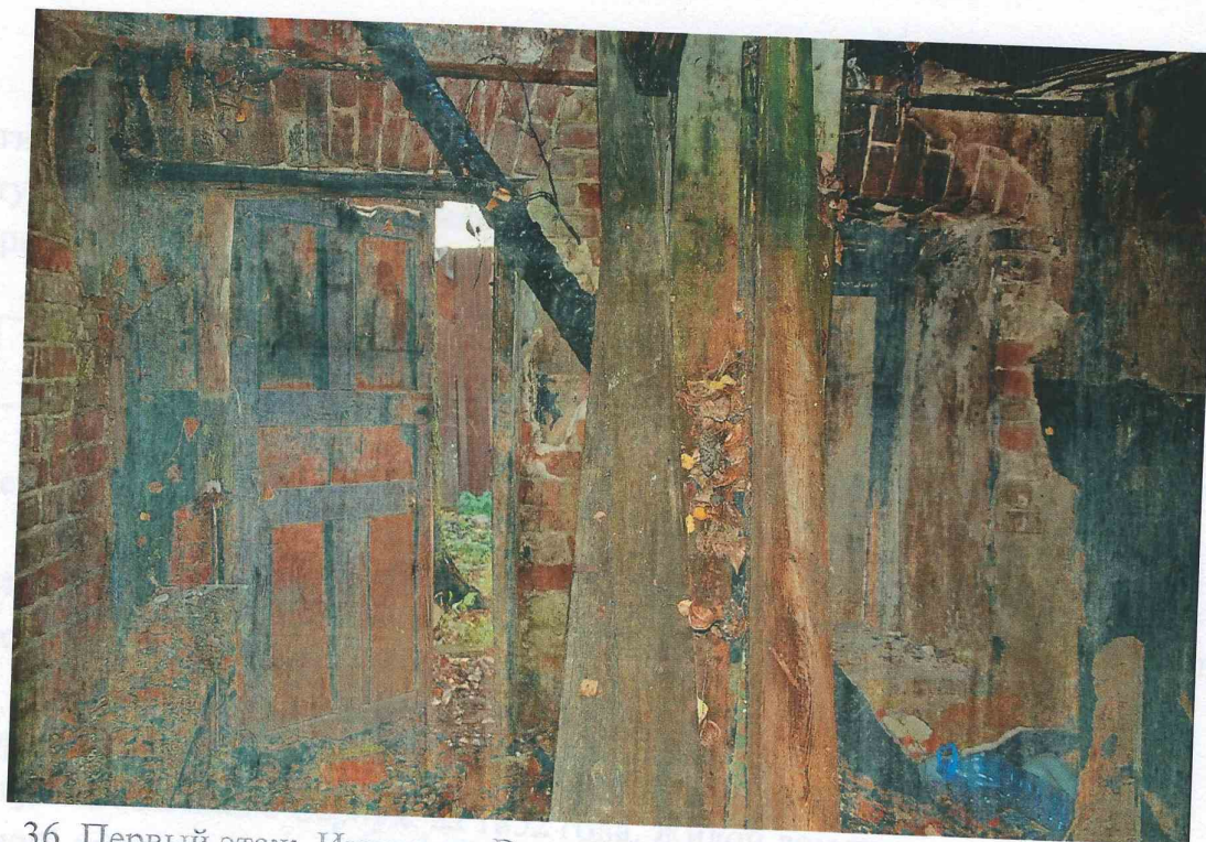
35. Первый этаж. Интерьер. Помещение в восточной части здания.
