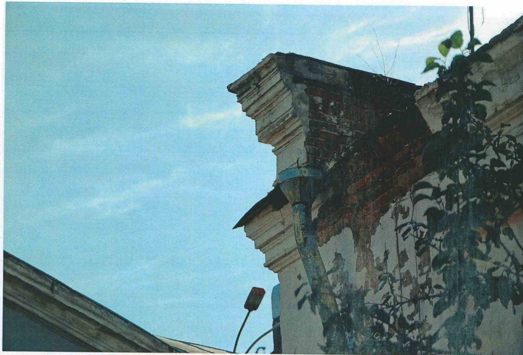
10. Западный фасад. Карниз. Фрагмент.
