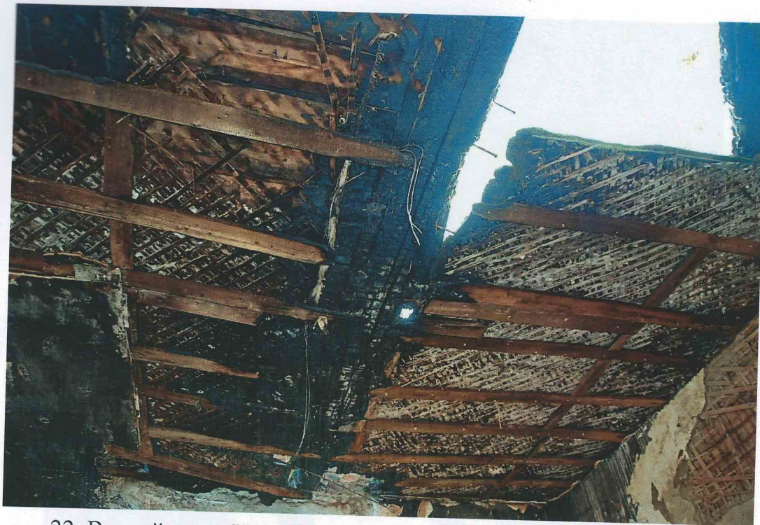
22. Второй этаж. Интерьер. Чердачное перекрытие. Фрагмент.
