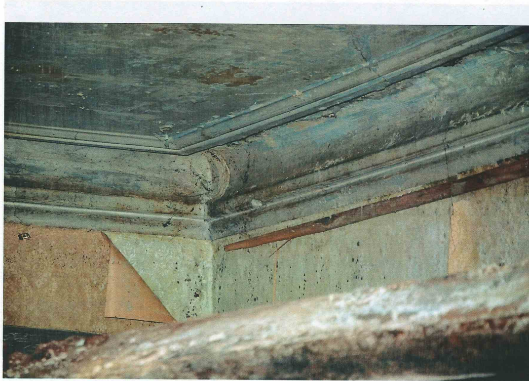
32. Первый этаж, интерьер. Профилированный тянутый потолочный карниз.
