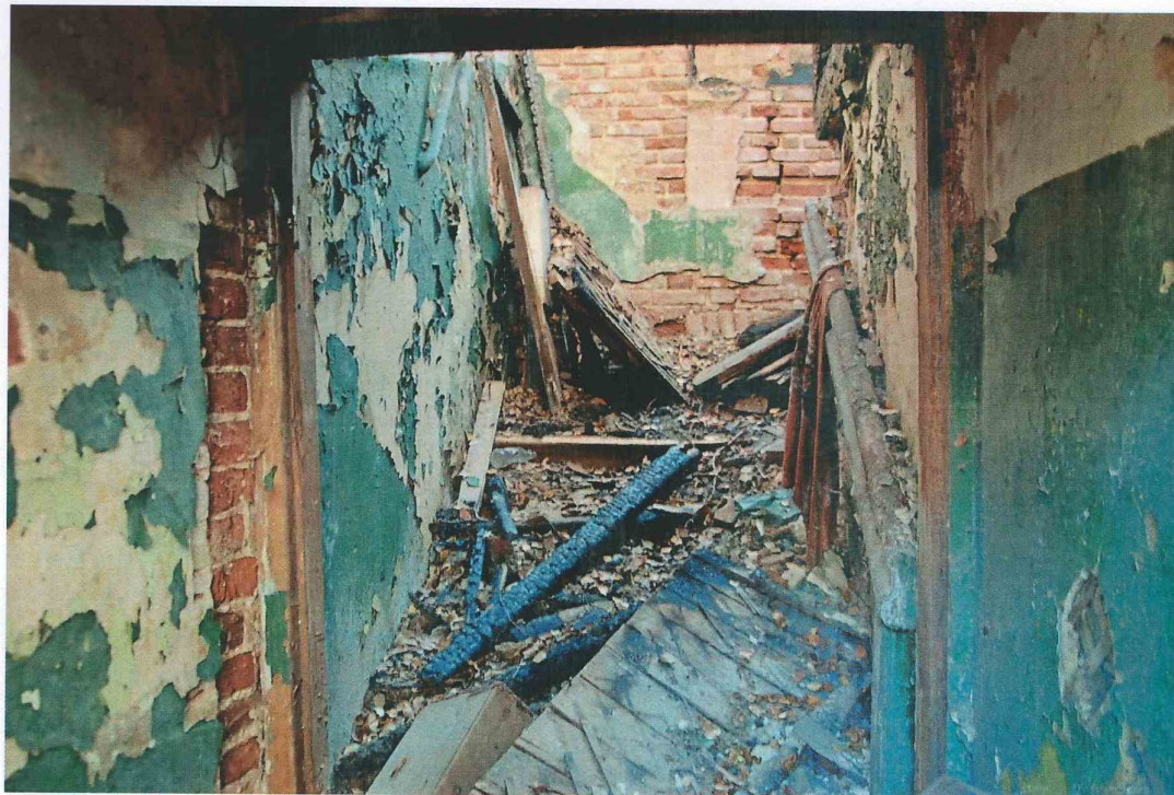
13. Нижний марш междуэтажной лестницы
