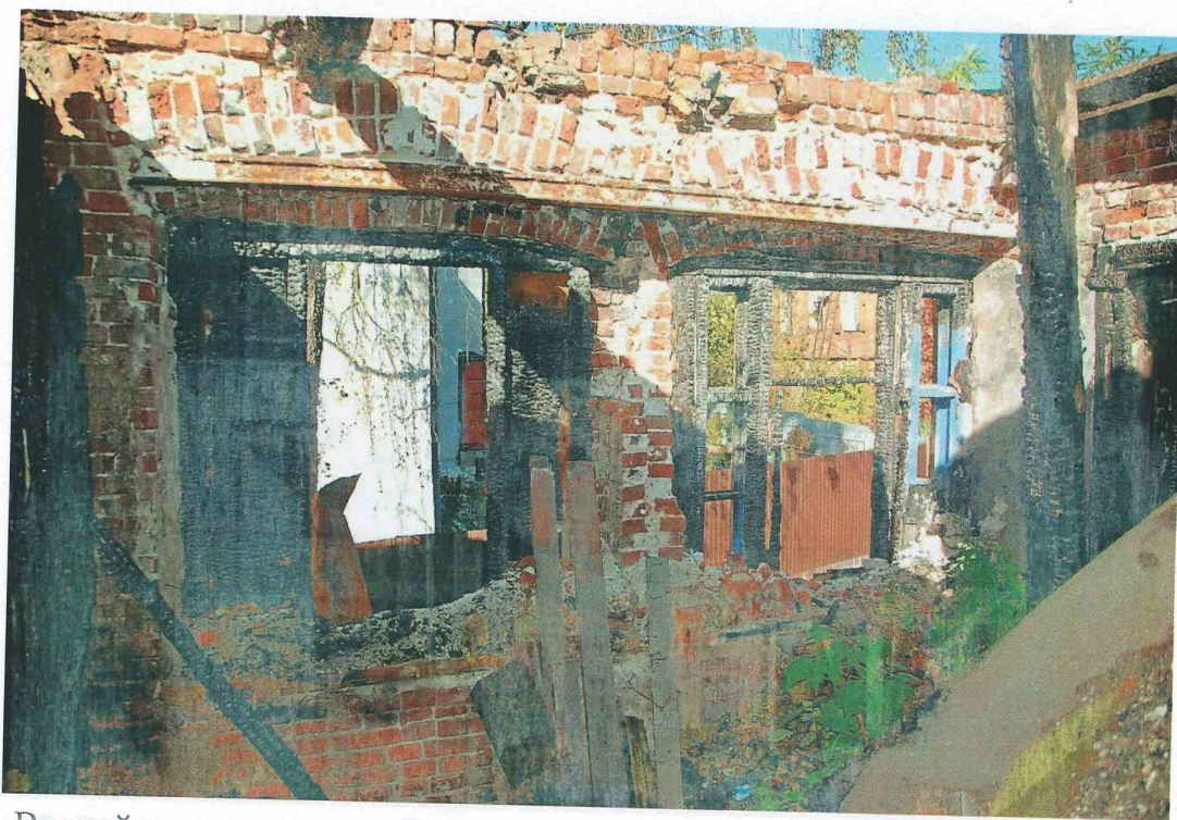
16. Второй этаж, интерьер. Вид на северную стену. Окна лестничной клетки.
