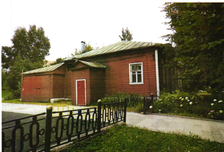
3. Вид с северо-запада на северный фасад дома. Фото 2018 г. Конфигурация, материал и характер кровельного покрытия крыши XIX в., высотные отметки по коньку, включены в предмет охраны. Характеристики элементов крыши уточняются в процессе комплексных научных исследований и осуществления производства реставрационных работ.
