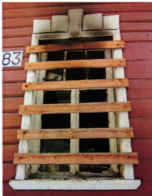
9. Существующие столярные заполнения в оконных проемах дома.
