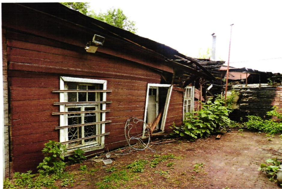
4. Восточный фасад дома. Фото 2023 г. Элементами предмета охраны являются композиционное решение и архитектурно-художественное оформление фасадов здания XIX в., в том числе: местоположение, форма и размер оконных и дверных проемов конструкция и материал бревенчатого сруба XIX в., сложенного «в обло».
