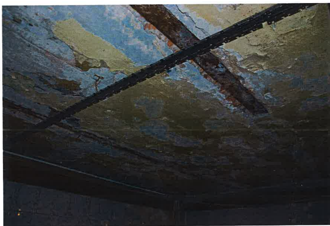
38. Подклет. Перекрытие. Фрагмент.
