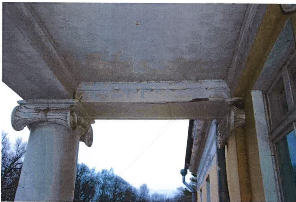
30. Потолок лоджии, вид на восток.
