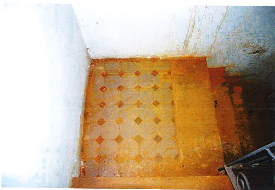
34. Поворотная площадка лестницы в подклет. Мощение метлахской плиткой, 1910-е годы.
