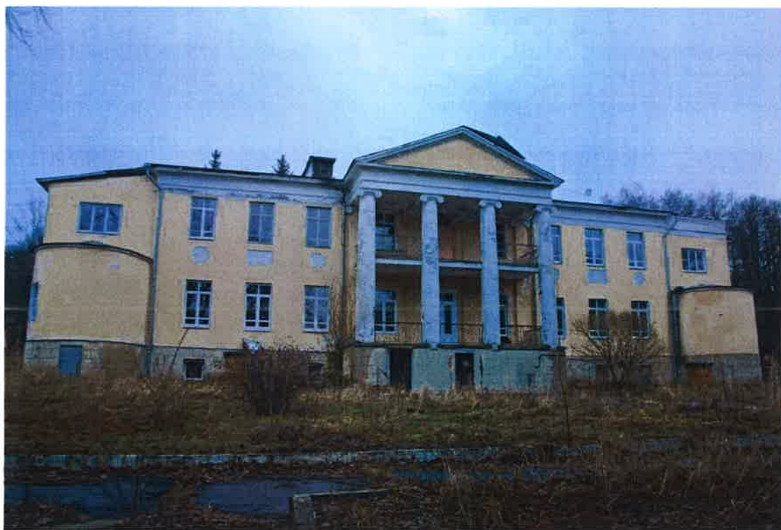
4. Вид с севера. Главный фасад.
