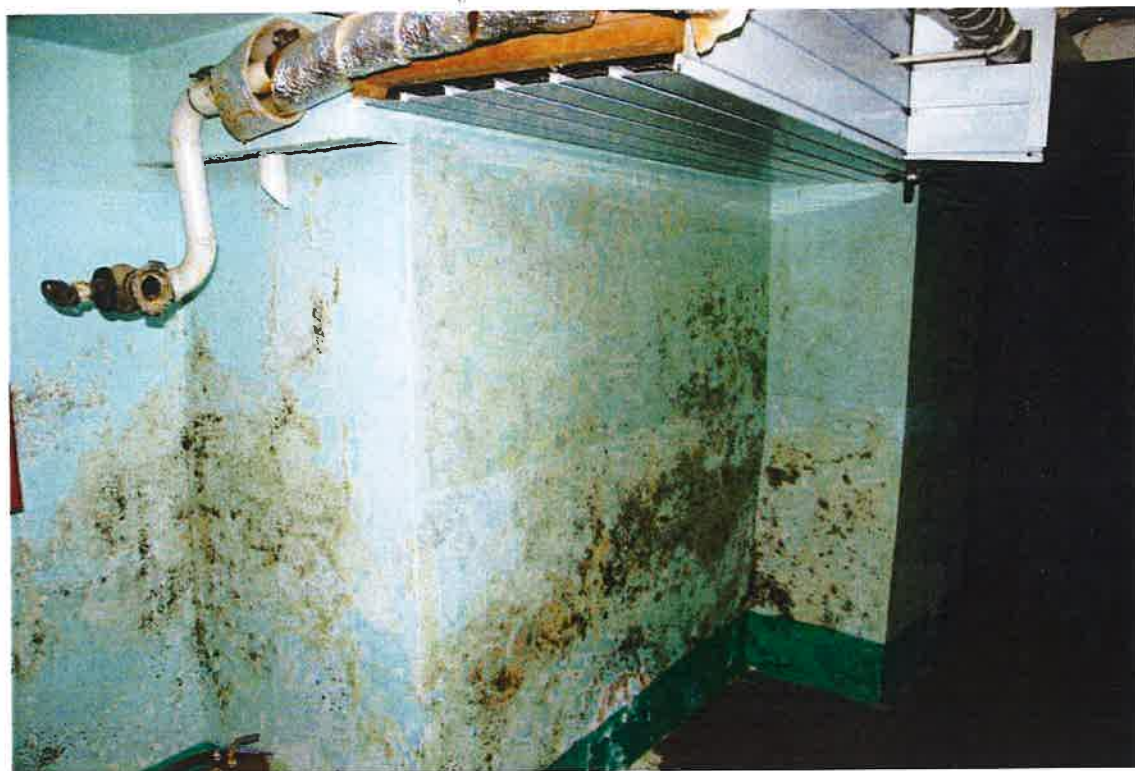
37. Подклет. Коридор. Зона биопоражения грибком.
