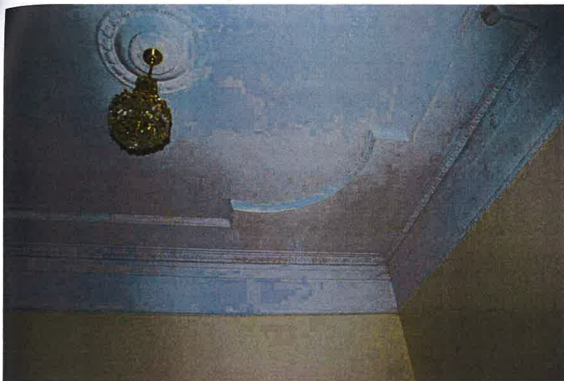
17. Центральный зал северной анфилады. Потолок. Фрагмент.
