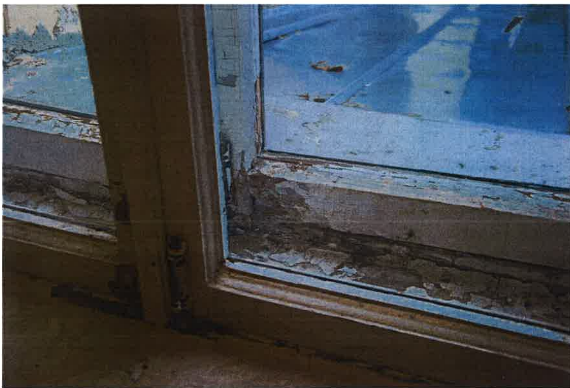
32. Оконное заполнение 1910-х годов. Фрагмент. Калёвка.
