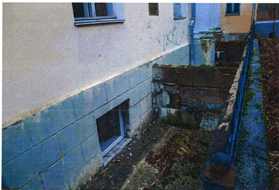
42. Восточный приямок у южной стены. Цоколь.
