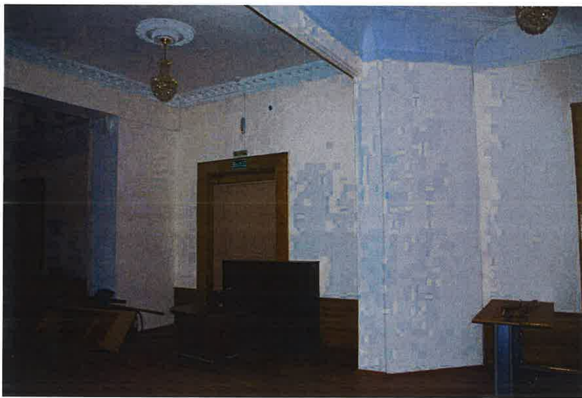
14. Заштукатуренные угловые печи. Дверной проём выхода в вестибюль.
