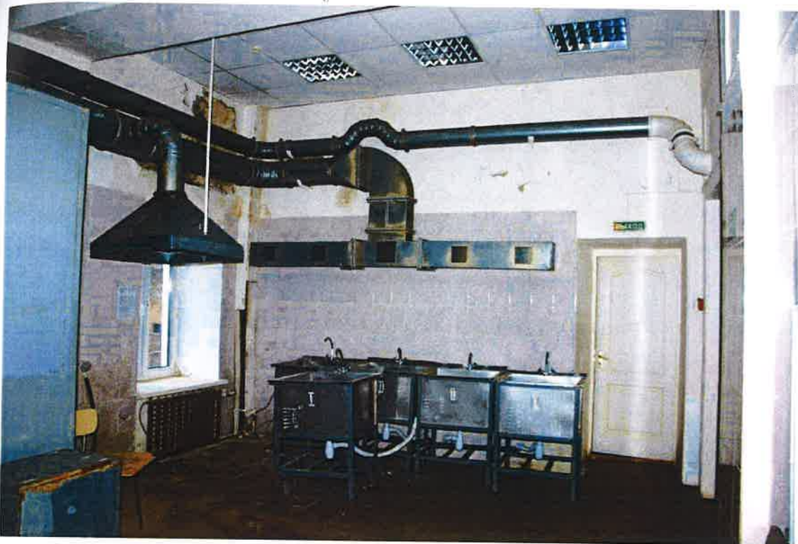
19. Пищеблок в восточной части первого этажа. Вид на юго-восточный угол помещения.
